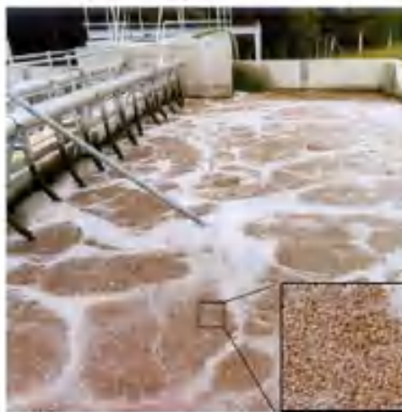
Рисунок 6.5 – Фото реактору з рухомим шаром Kaldnes,
