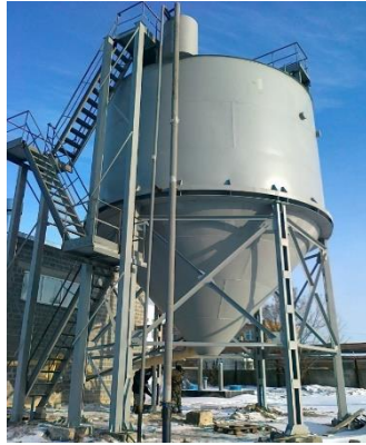
Рис. 1. Відстійник-флотатор на очисних спорудах Золотоніського маслоробного комбінату
