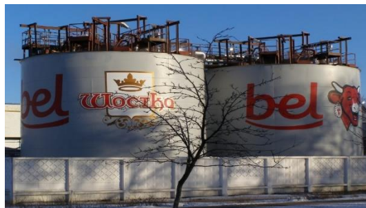
Рис. 2. Аеротенки-відстійники великої гідравлічної висоти у складі очисних споруд Шосткінського міськмолзаводу
